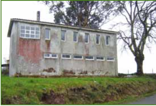
Estado actual do inmoble
