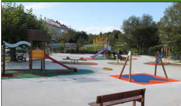
O Concello investiu máis de 40.000 euros na rehabilitación do parque infantil de Sigüeiro
