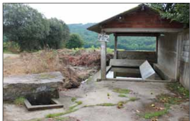
Concello de Oroso comprometeuse cos veciños do Piñeirón a recuperar a fonte e o lavadoiro desta localidade da Gándara
