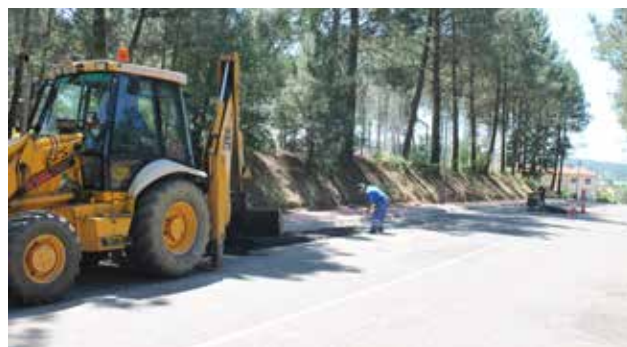
A brigada de obras aproveitará o verán para facer asfaltados polo municipio, como esta ampliación da rúa María Casares
