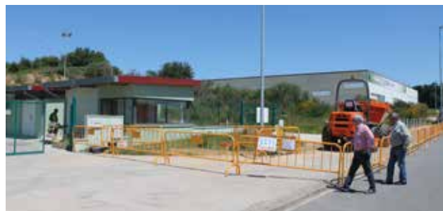
Comezan as obras para levar a electricidade ao punto de reciclaxe Sigüeiro Verde, que abrirá as súas portas en breve
