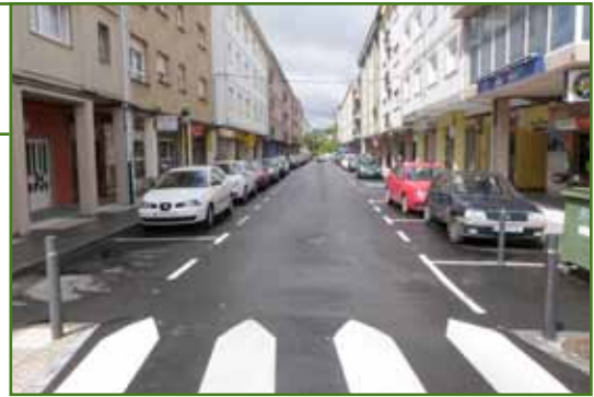
As obras incluíron nivelación de beirarrúas, novo saneamento e novo aglomerado, con aparcamento en liña
