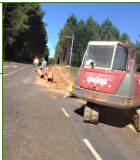
O Concello de Oroso vén de iniciar as obras na rúa María Casares
